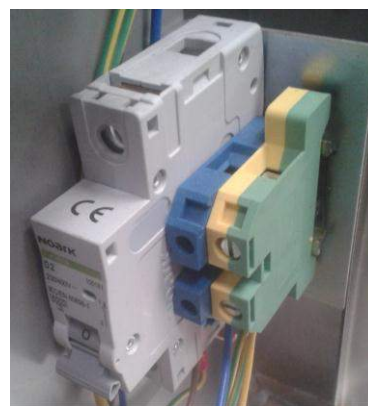
Рисунок 13– Подключение кабеля питания
